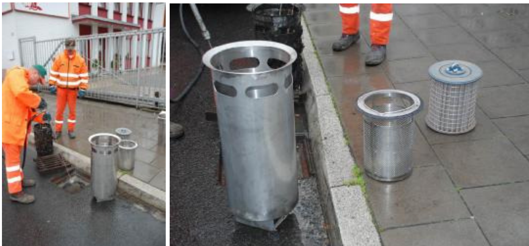
Abb. 7: Nachrüstung in der Eilper Straße
